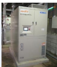
ヒートポンプ
