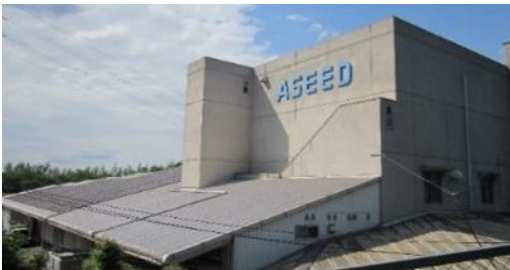
アシード福山支店倉庫屋根へ太陽光パネルを設置し、自販機100台程度の消費電力を売電
