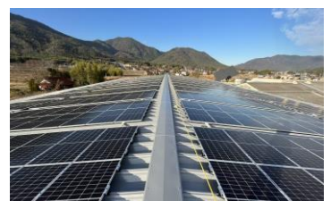
太陽光パネル
