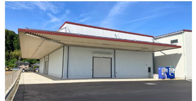
南倉庫の建設
